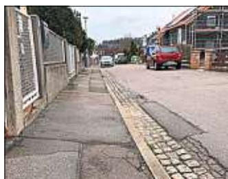
Die Max-Schulze-Straße wird saniert. 150 000 Euro stehen dafür zur Verfügung.
